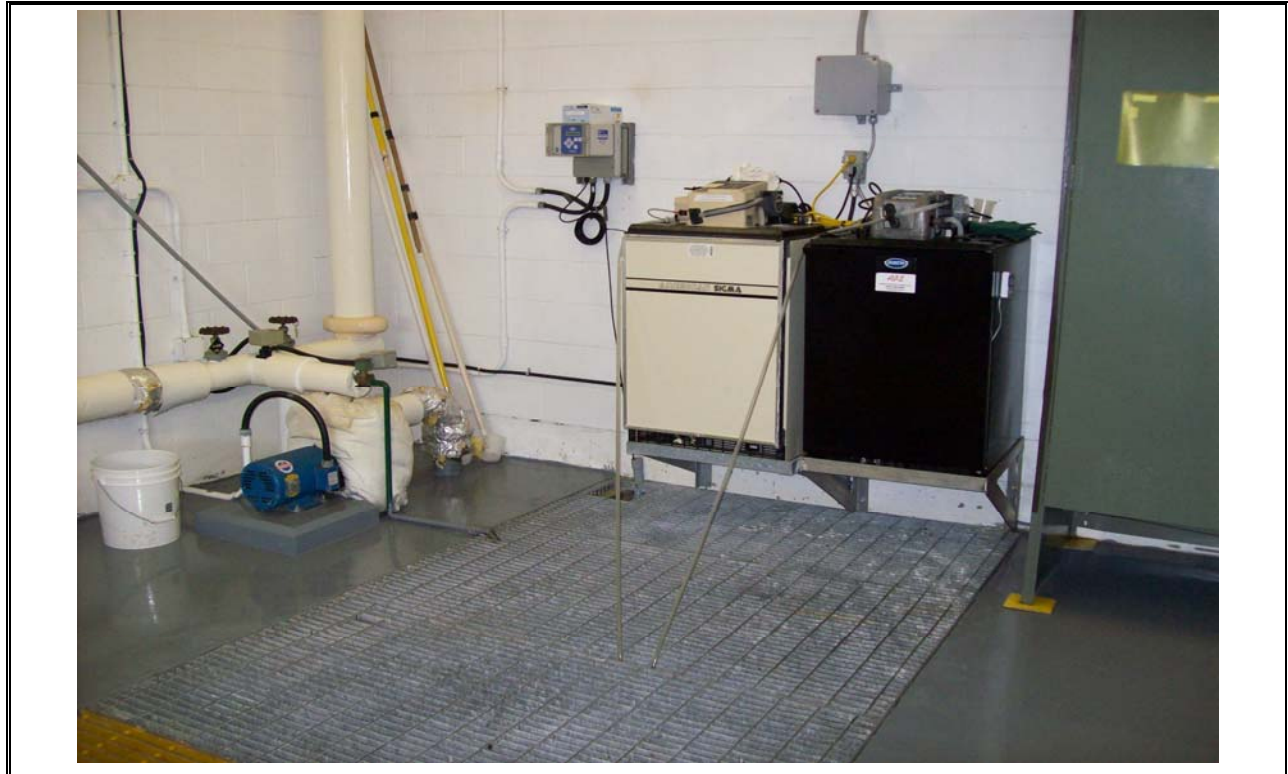
Photo 43 Effluent Autosampler
