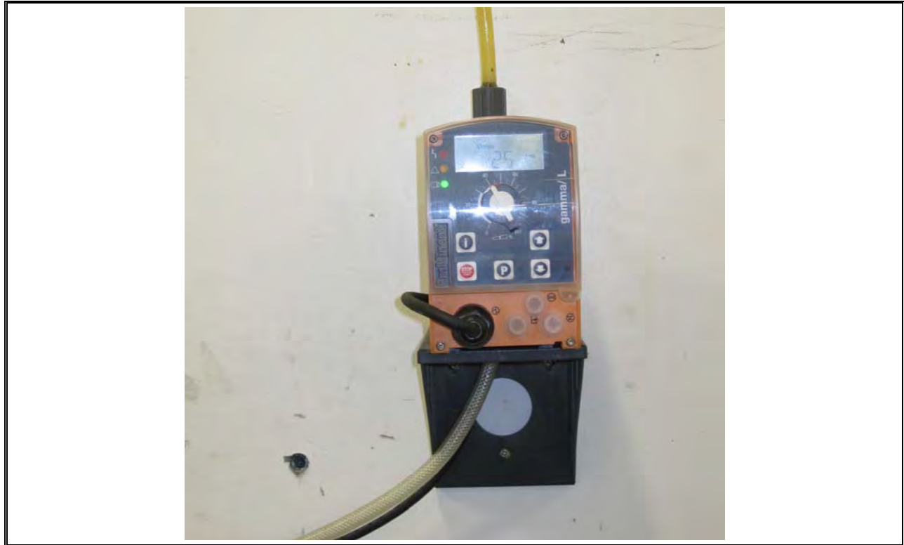
Photo 25 Dartmouth Effluent Metering
