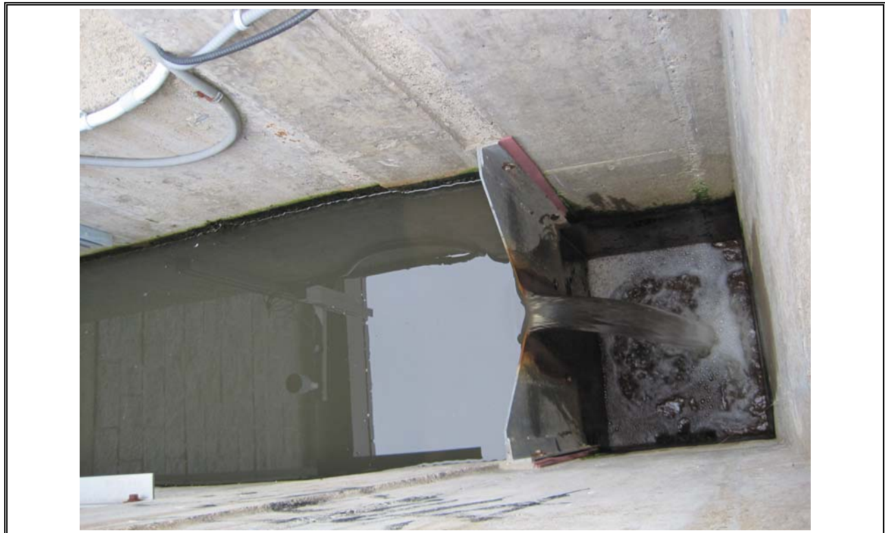
Photo 20 Effluent V-Notch Weir
