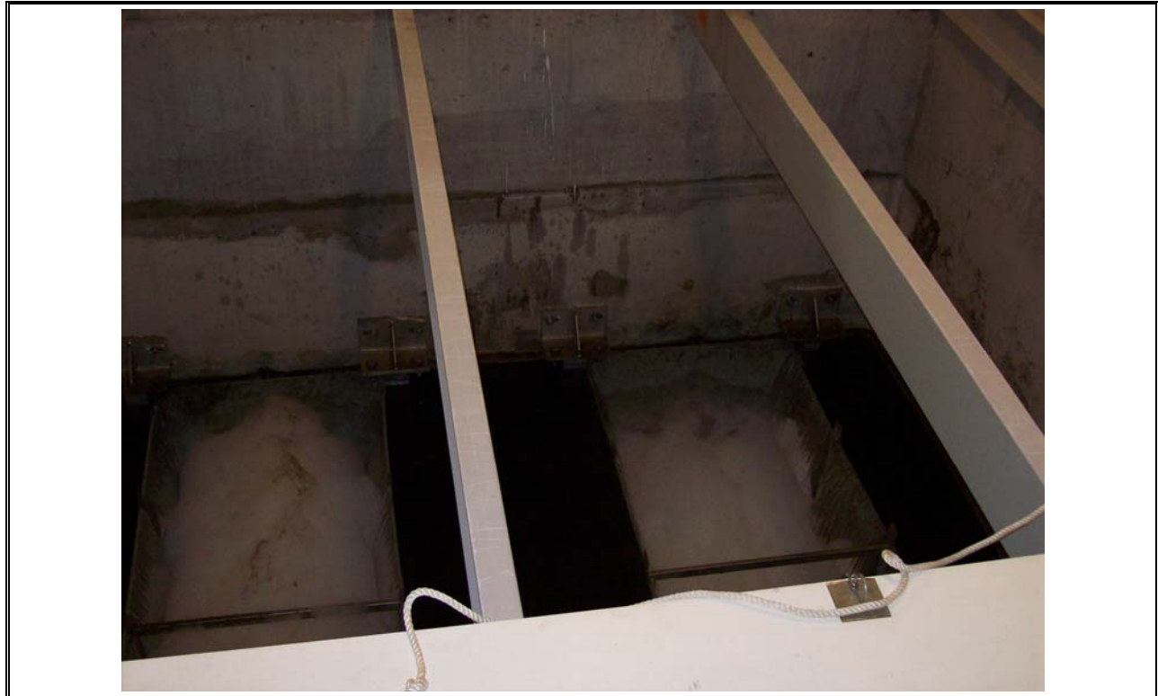
Photo 19 Halifax Densadeg Effluent Troughs
