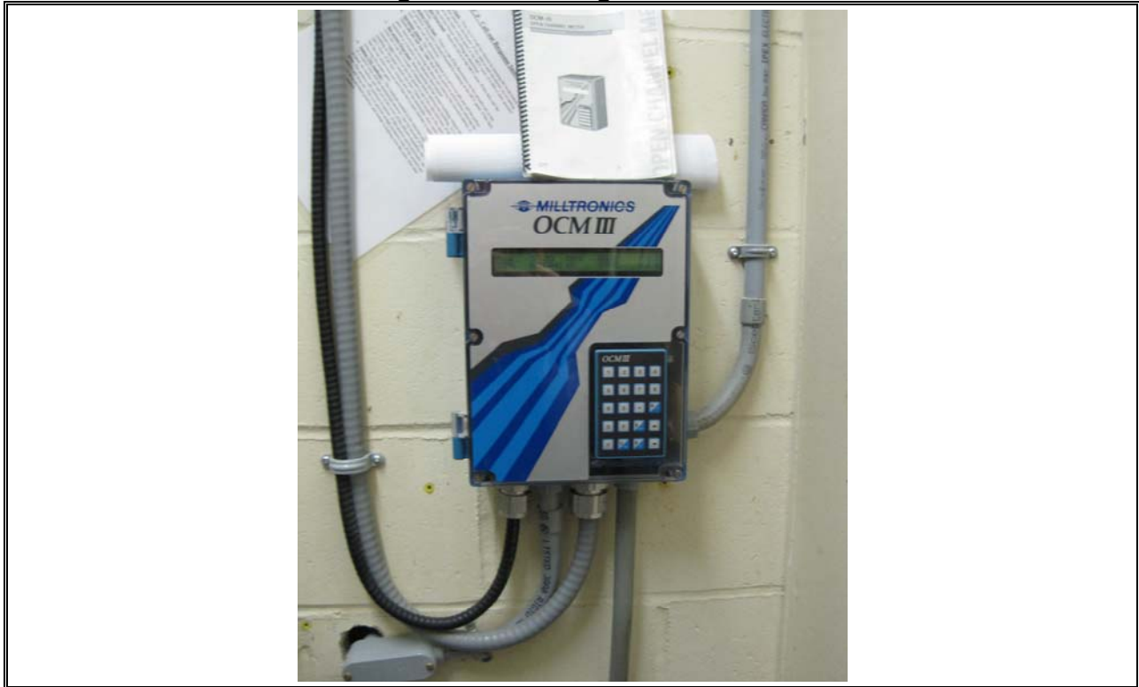
Photo 28 Effluent Flow Meter
