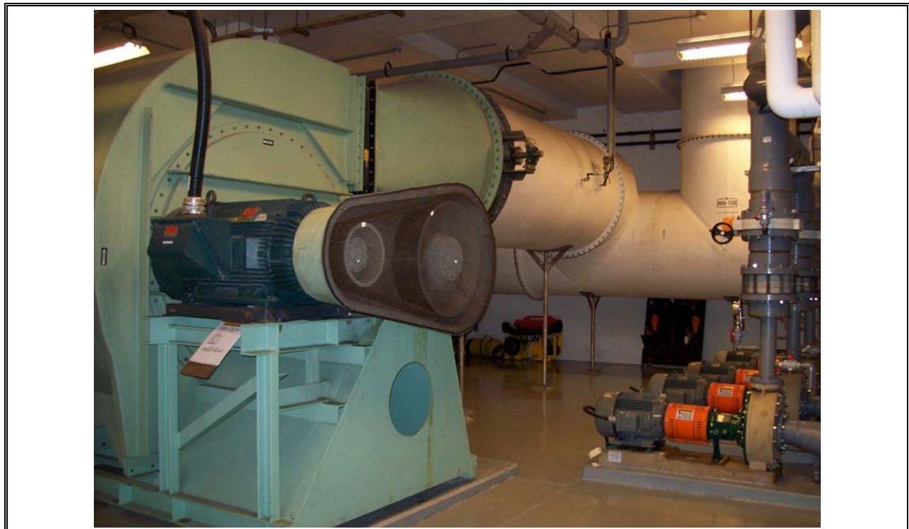
Photo 36 Halifax Odour Control Foul Air Fan
