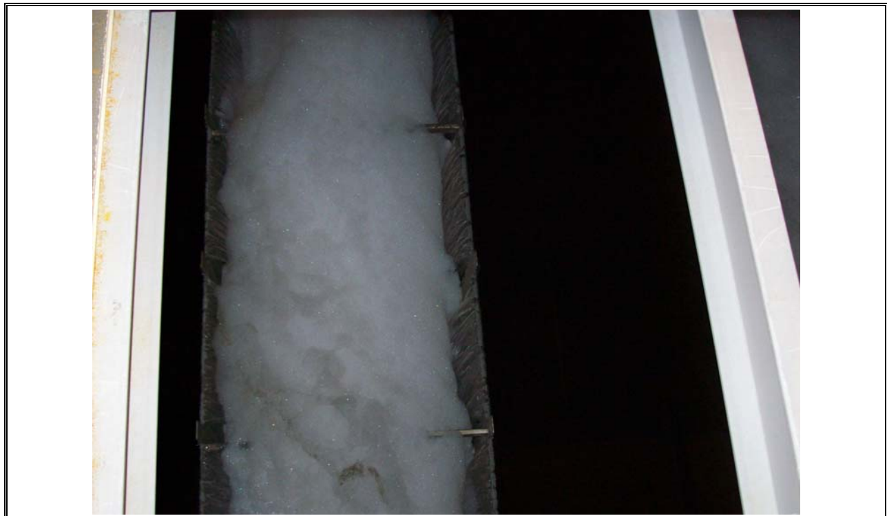
Photo 18 Halifax Densadeg Effluent Trough
